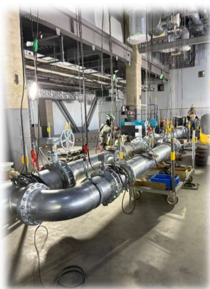
◎難しい吊り込みも安全に！
