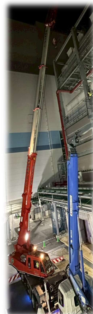
◎重機を使用し夜間に取付
